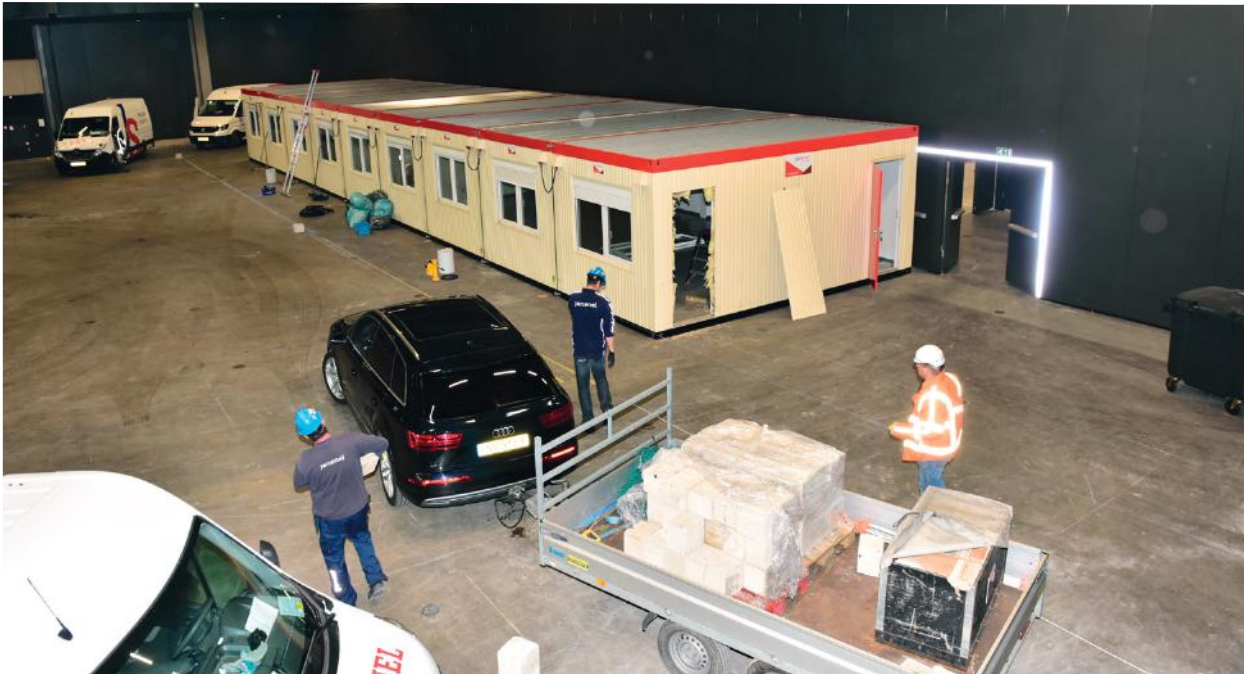
Met systeembouw werd een compleet ziekenhuis gerealiseerd in Ahoy.
